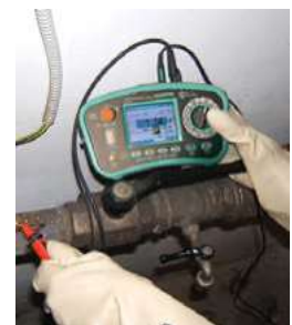
Continuity check of equipotential bonding
